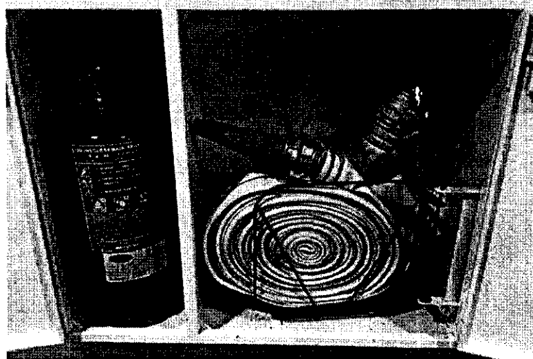
(Skapis ar pulvera ugunsdzēsības aparātu un UK ar šļūteni un stobru)
